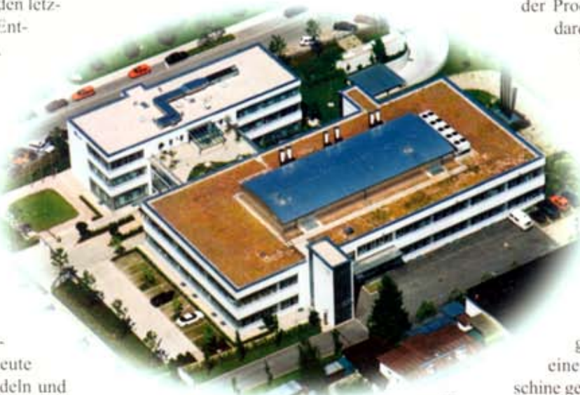
Der Gebäudekomplex von VDW in München.
