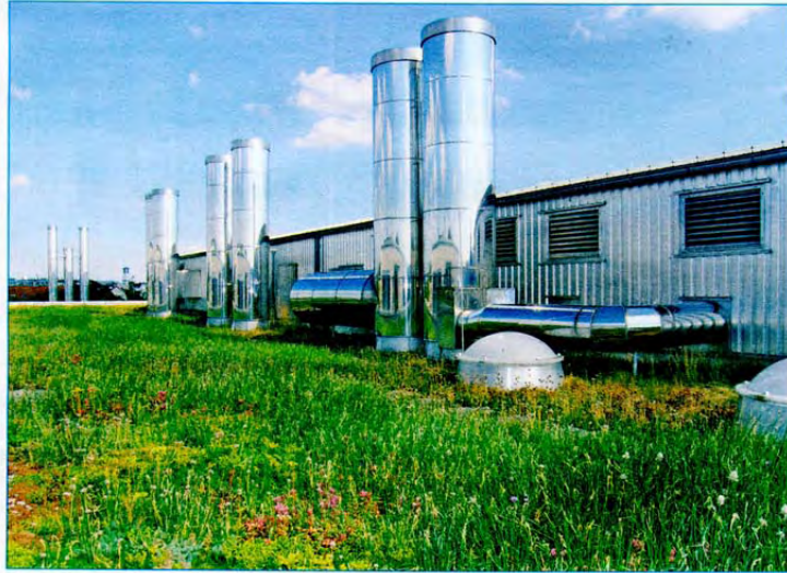
Für den „metallverarbeitenden Betrieb“ gelten heute hohe Umweltschutzauflagen. Große Filteranlagen und ein begrüntes Dach sind Teil der Schutzmaßnahmen.
